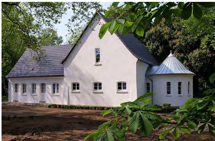
Nach der Renovierung, Mai 2009, Foto: Josef Uhe
